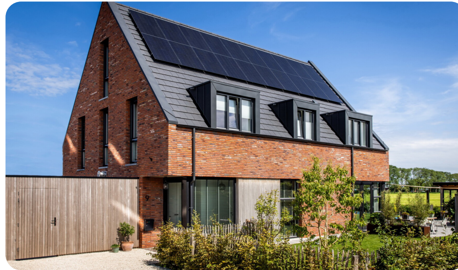
Detaillering in afwisselend gebruik in materialisatie
