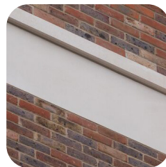
strakke betonnen latei
