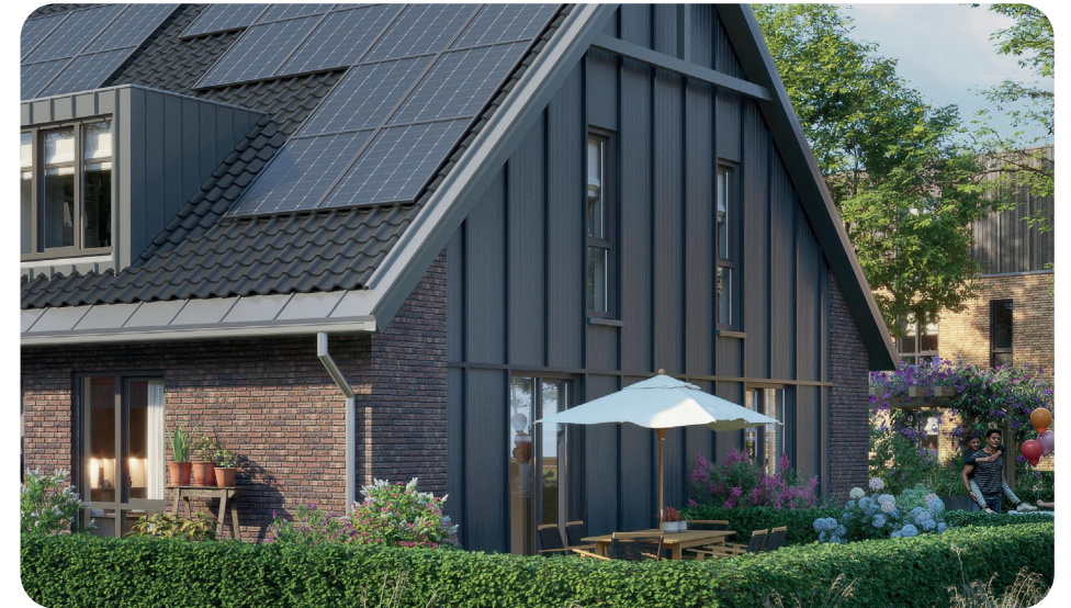
Verbijzondering kopgevel met afwijkende materialisering
