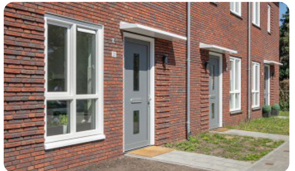
Diepte aanbrengen in gevelvlak door mestelwerk en gevelopeningen
