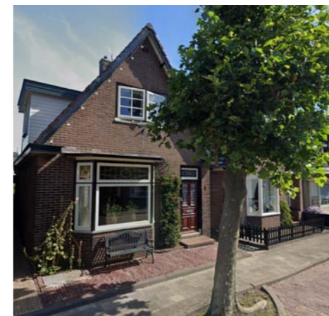
Overgang openbaar en privé zonder hek met andere bestrating en groen aan gevel
