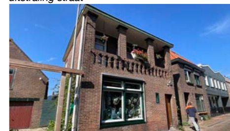
Bijzondere gemetselde gevel
